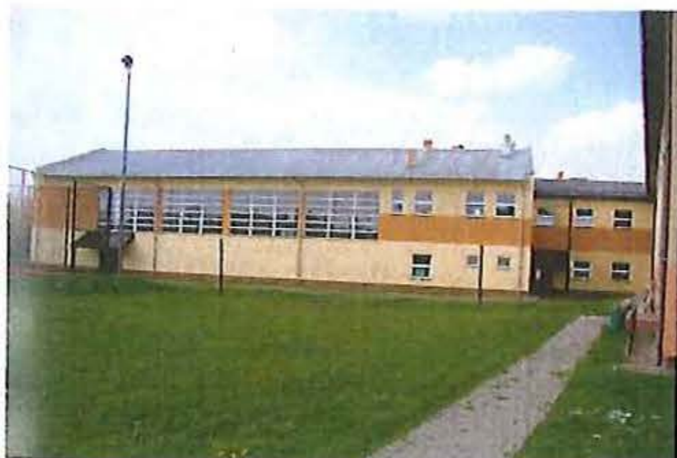
Przyszkolna hala sportowa w Potoku Wielkim
